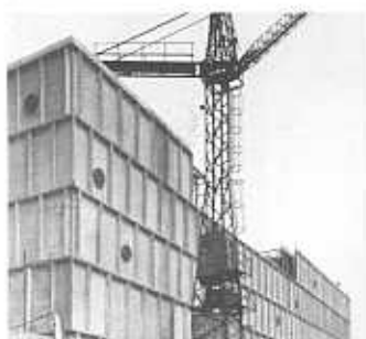
Hűtőház, Békéscsaba, szerkezetépítés közben (1958–62)
