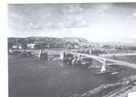
MARGIT HÍD ÚJJÁÉPÍTÉSE, BUDAPEST, 1945-47.
